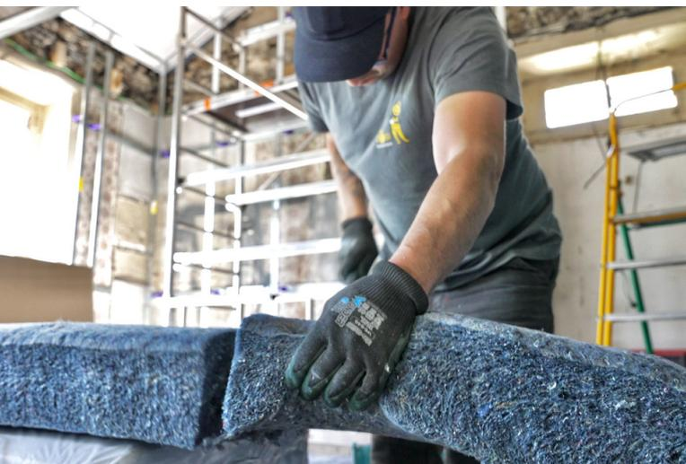
Le procédé COTOWOOL FLEX 25 fait l'objet d'Avis Technique (n°20/19-439\_V2 Application murs, 20/19-440\_V2 Application combles). Il est destiné à l'isolation thermique en travaux neufs ou en rénovation des bâtiments suivants :
