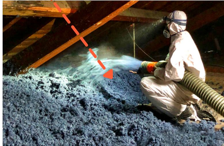
Le procédé COTOWOOL VRAC fait l'objet d'Avis Technique n°20/17-398\_V1. Il est destiné à l'isolation thermique de planchers de combles perdus et entre solives et fermettes, en travaux neufs ou en rénovation, des bâtiments suivants :
